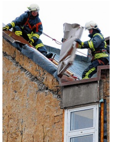
Heikler Einsatz: Die Feuerwehrmänner Matthias Brumm und Marco Guthardt entfernen absturzgefährdetes Kupferblech in 13 Metern Höhe vom Dach des Amtsgerichts Eckernförde.
