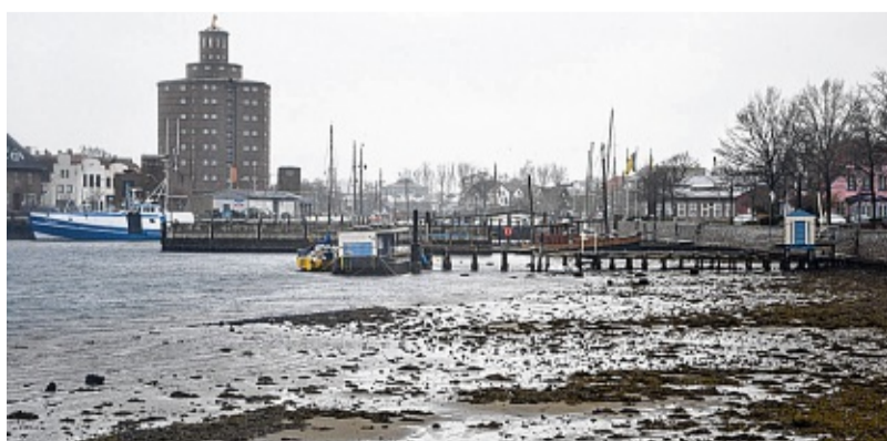
Der starke Südwestwind trieb das Wasser aus dem Hafen. BRANDAO
