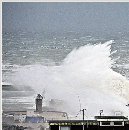
Auf Helgoland brachen die Wellen spektakulär an den Hafenanlagen.
