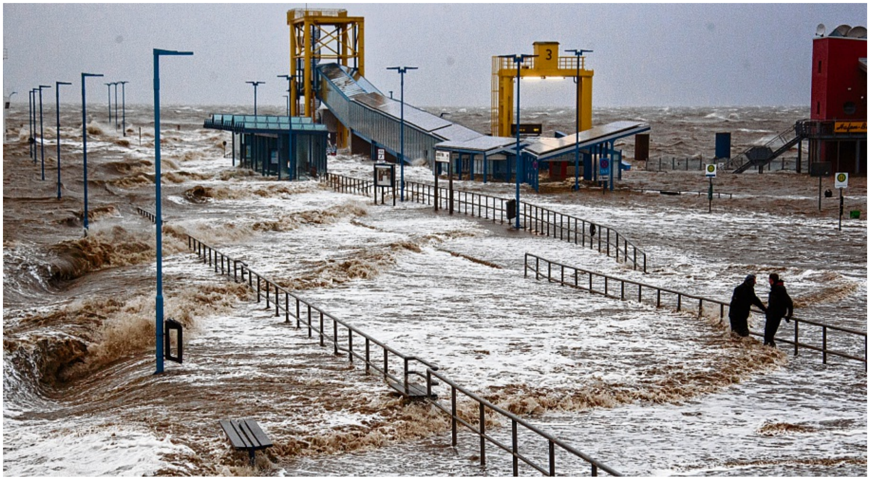
Wellen überspülen den überfluteten Fähranleger in Dagebüll mit voller Wucht. Aus „beinahe“ sicherer Distanz wird das Naturschauspiel begutachtet.
